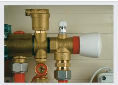
La valvola differenziale di by-pass Giacomini R147N può essere installata come componente indipendente sia in centrale termica sia in sottostazioni di distribuzione (cassette collettori) e come sottocomponente dei gruppi premontati per caldaia Giacomini Serie R586 o dei collettori di distribuzione per impianti a pannelli radianti R557.
