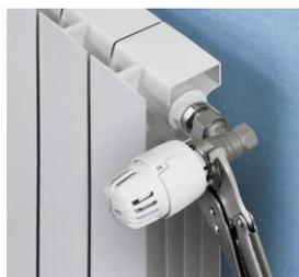
**4** - Avvitare la ghiera metallica zigrinata della testa termostatica, sul corpo valvola fino al suo bloccaggio. Dopo il montaggio della testa, ruotare alcune volte la manopola numerata, da posizione "5" a posizione "\*", per un assestamento delle parti.
