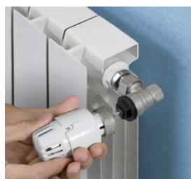
**2** - Portare la manopola numerata della testa termostatica in posizione "5", raggiungibile ruotandola in senso antiorario.
