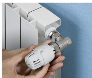
**3** - Posizionare la testa termostatica sul corpo valvola centrando l'esagono del cappelletto e lasciando la finestrella di riferimento alla regolazione rivolta verso l'alto o comunque in posizione visibile.
